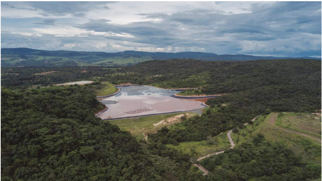
Turmalina Dam - Conceição do Pará
